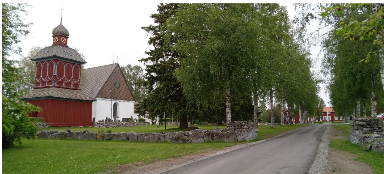
Klockstapeln uppförd 1767-68. Rakt in från kyrkplatsen vid Prästgården ligger det innehållsrika Hembygds museet, där vi fick en visning av Nordmalings hembygdsförening.
