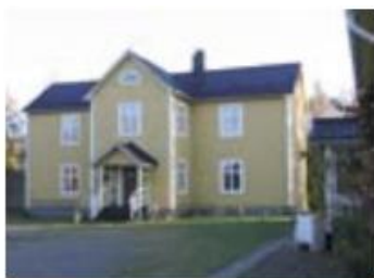
Borrmaskinen 20. Sandåsvägen 4 D.
